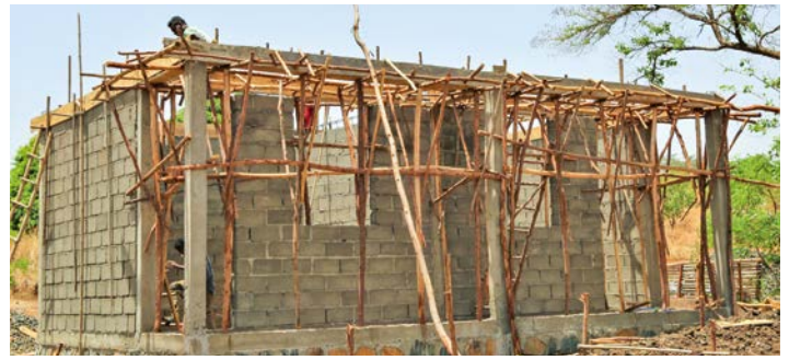
Die Baumaßnahmen am Frauenhaus in Homosha schreiten voran.
