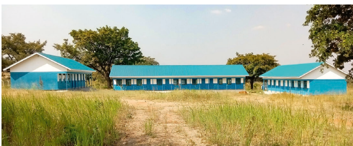
Neu errichtete Klassenräume einer Projektschule.
