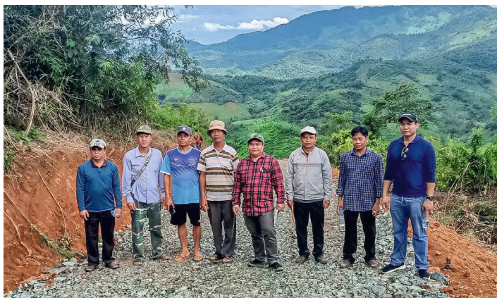
Für eines der Zentren wurde bereits eine Zugangsstraße errichtet
