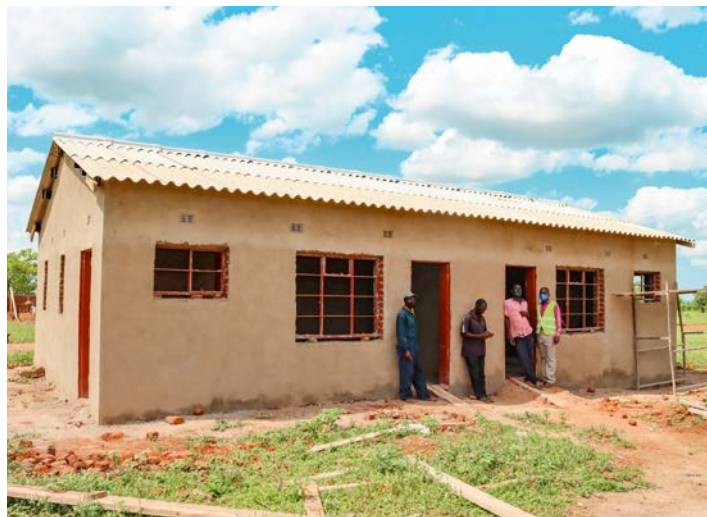
Eine der Lehrer:innenunterkünfte kurz vor ihrer Fertigstellung.
