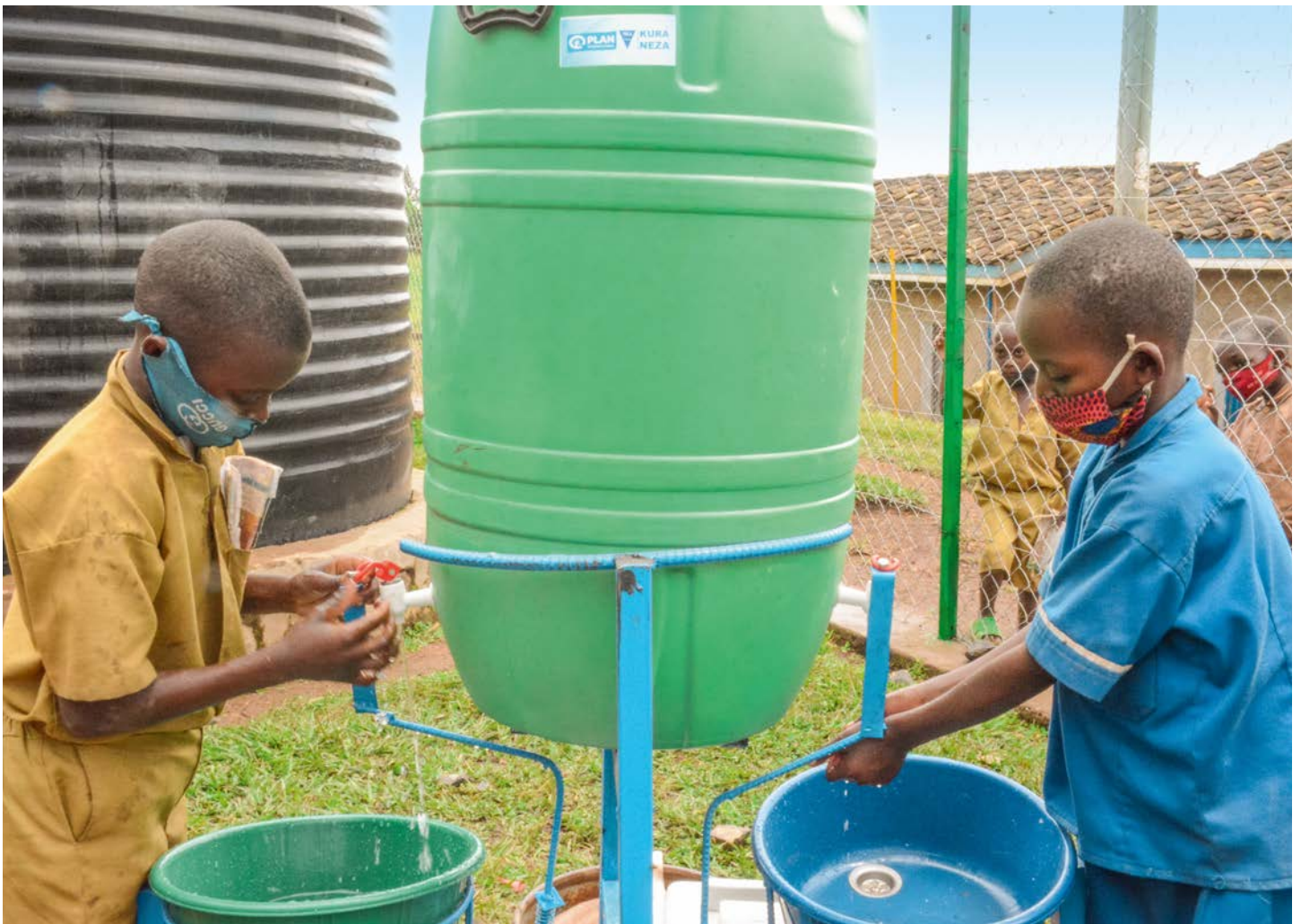
Errichtete Handwaschstationen helfen vor Infektionskrankheiten zu schützen.
