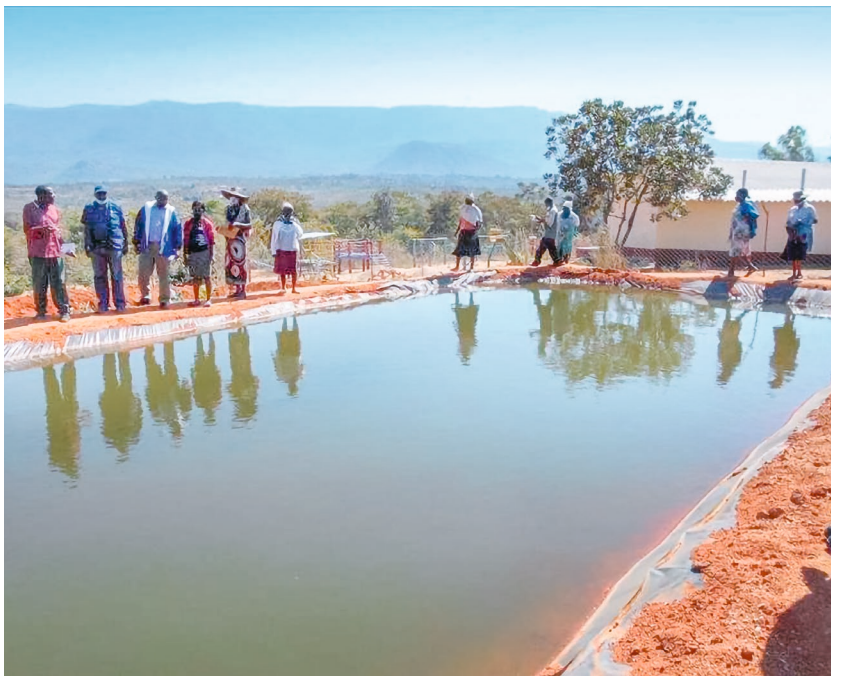
Drei weitere Fischteiche wurden fertiggestellt und mit Fischen bestückt.
