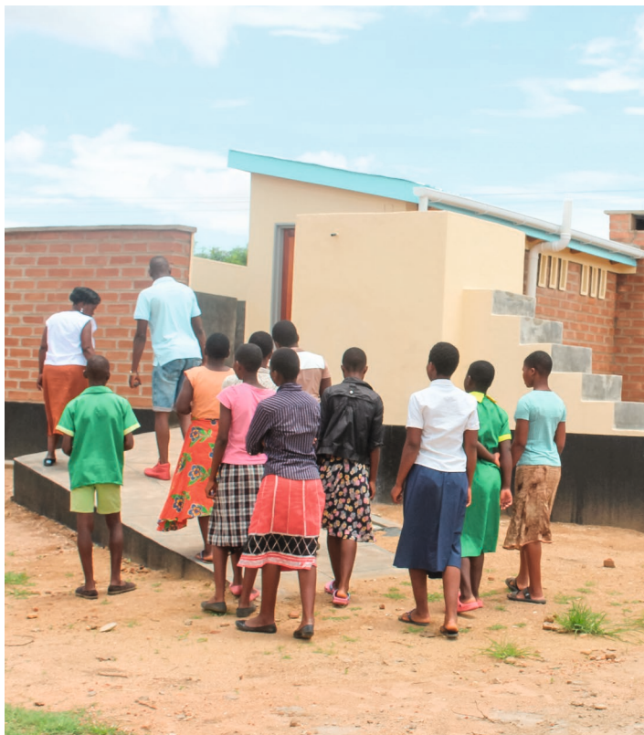
Besichtigung der neuen Sanitäranlagen.
