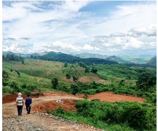
Vor dem Bau: In dieser abgelegenen Region in Bokeo ist ein neues Lernzentrum entstanden. © Plan International
