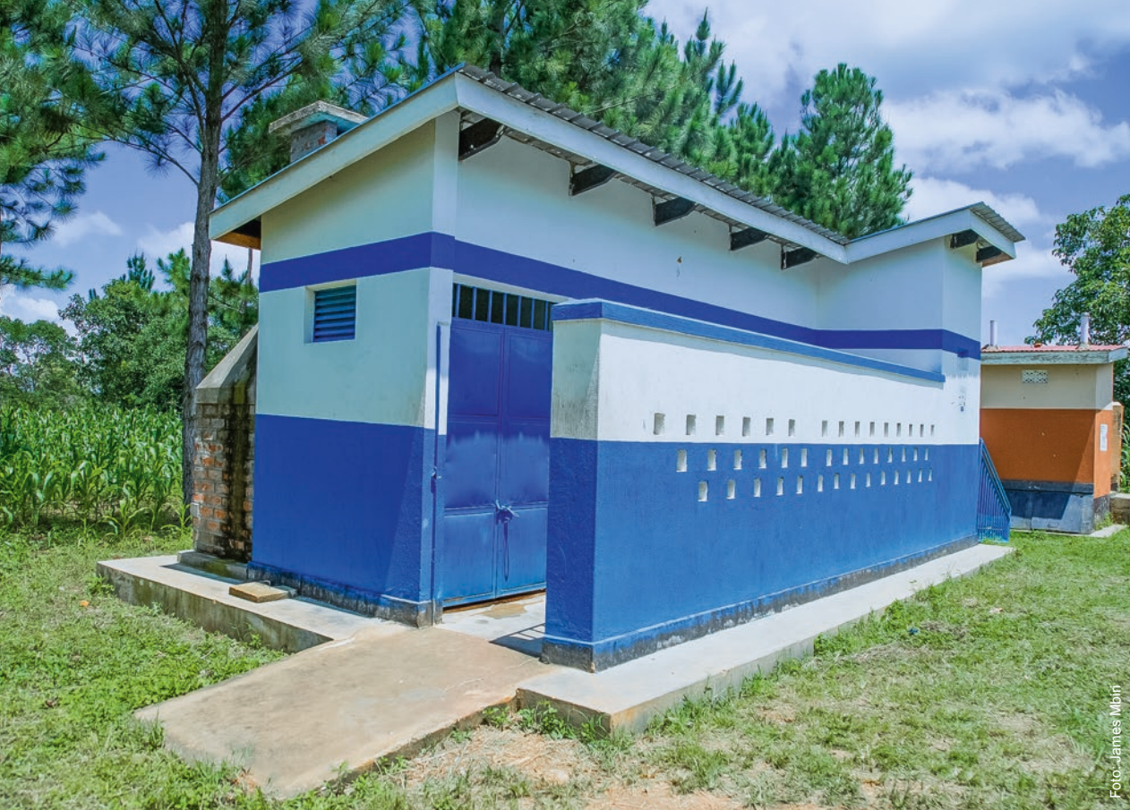
An sechs Schulen bauen wir neue Toilettenblöcke
